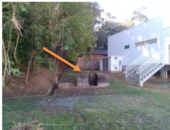
Figura 01 - rampa a ser demolida
