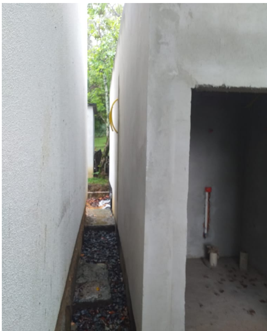
Foto 1: Banheiro – Parede leste
