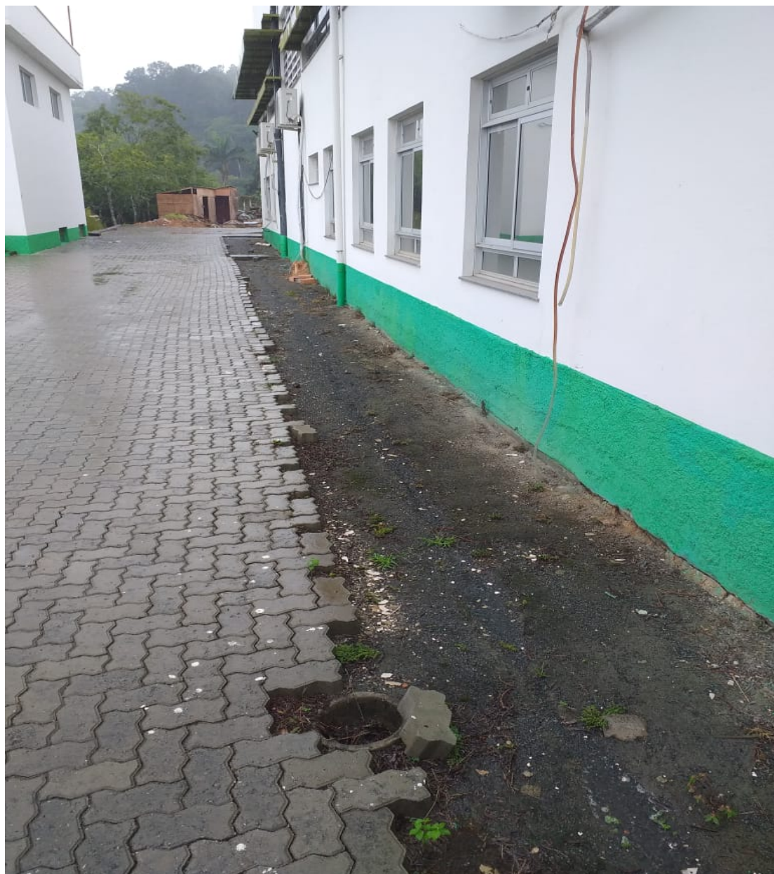
Foto 6: Estacionamento – Bloco A norte
