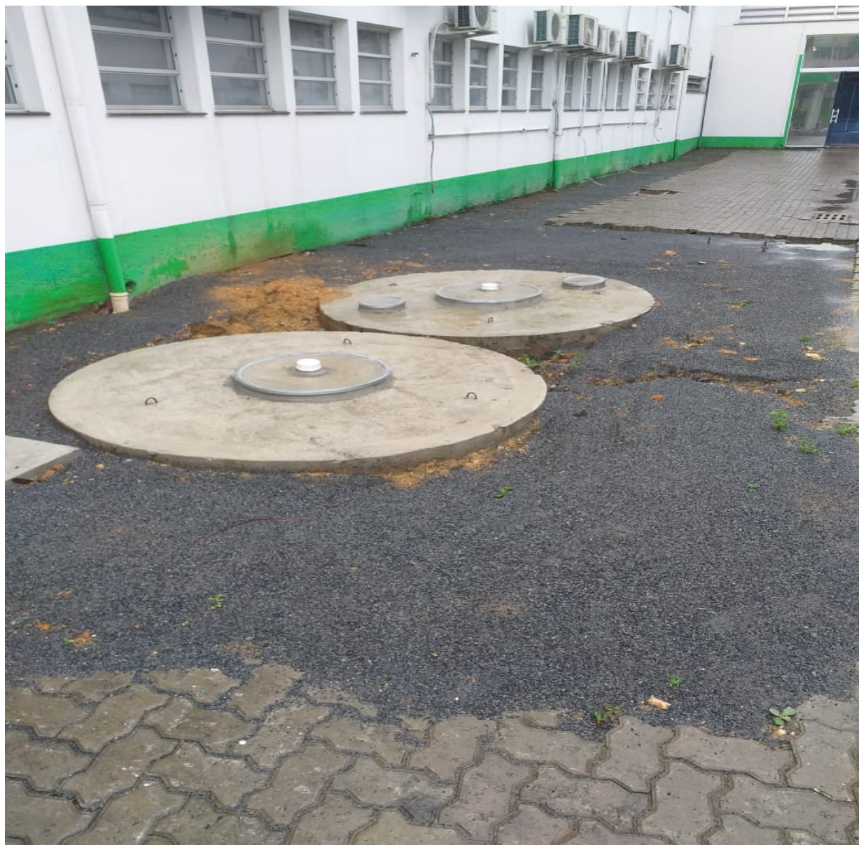
Foto 10: Estacionamento – Bloco B fossas
