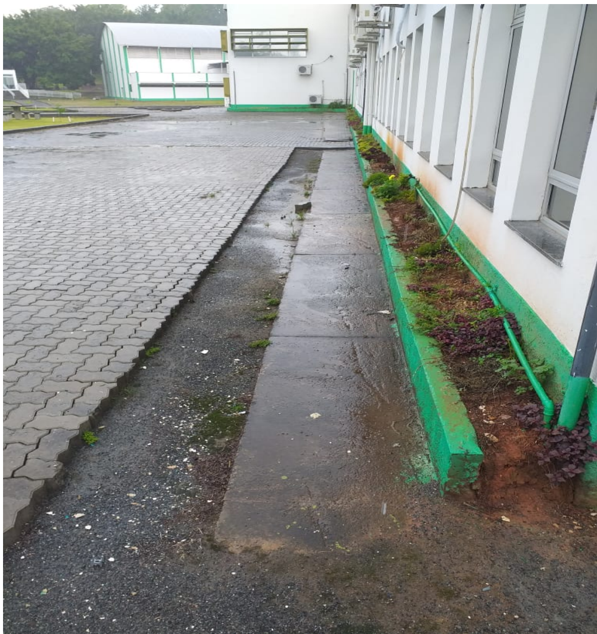
Foto 13: Estacionamento – Bloco D
