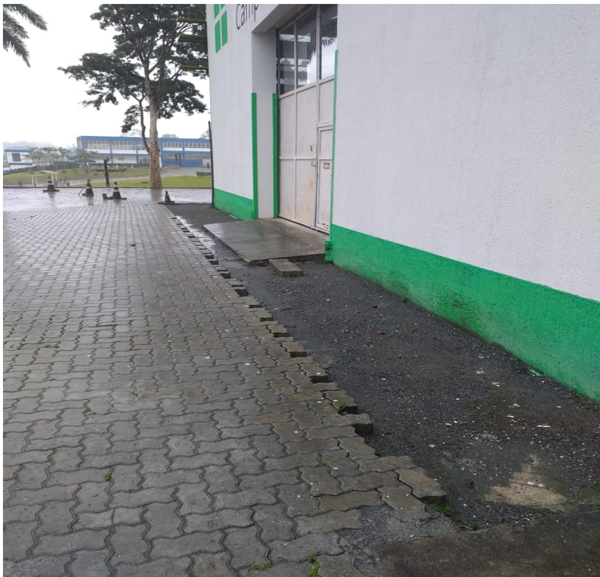
Foto 7: Estacionamento – Bloco A oeste
