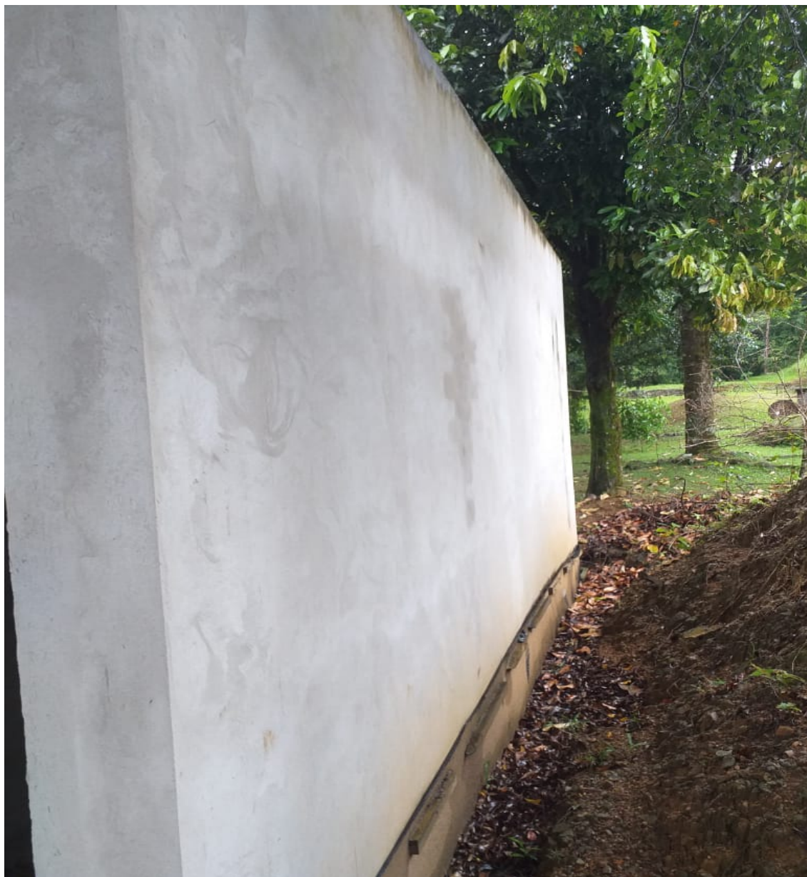
Foto 2: Banheiro – Parede oeste
