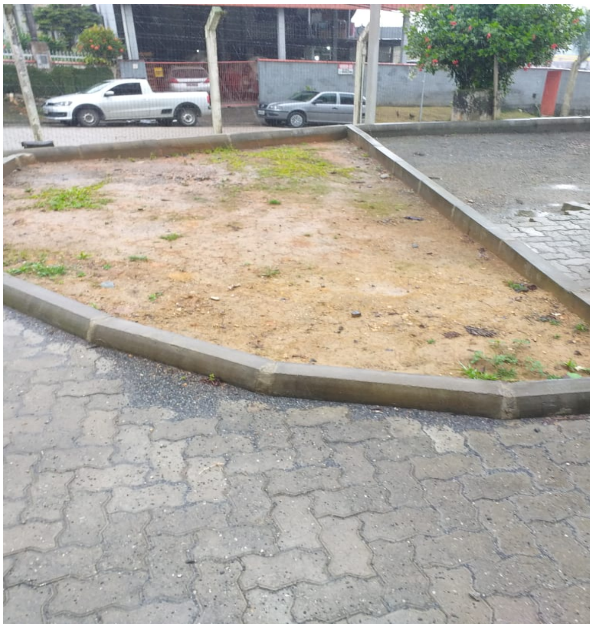
Foto 8: Estacionamento – Hall Bloco B
