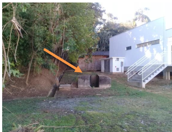
Figura 01 - rampa a ser demolida
