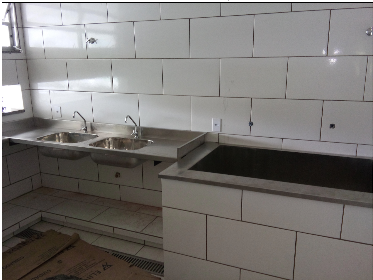
FOTO 7 – LAVATÓRIO DE UTENSÍLIOS E ALIMENTOS
