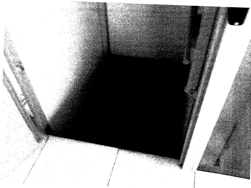
3-) Falha no sistema de segurança de acesso. Foi possível abrir a porta de acesso com a plataforma desnivelada com o piso e também com a plataforma em outro andar.
